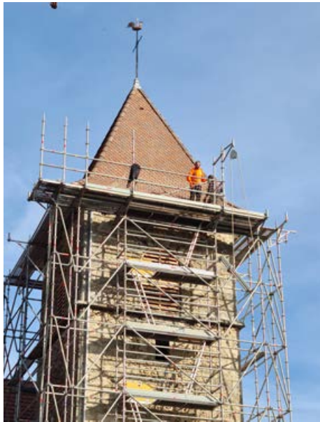
Tuiles et couverture du clocher
