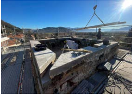
Support en maçonnerie
