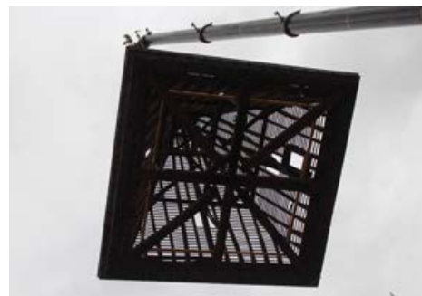
Descente de l'ancien clocher
